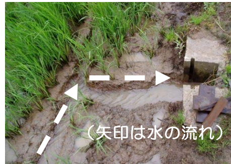
【溝の末端を排水口に接続した状態】
