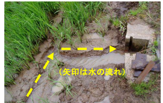
【溝の末端を排水口に接続した状態】
