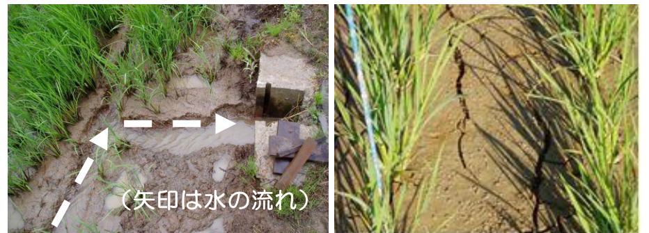
【溝の末端を排水口に接続した状態】
